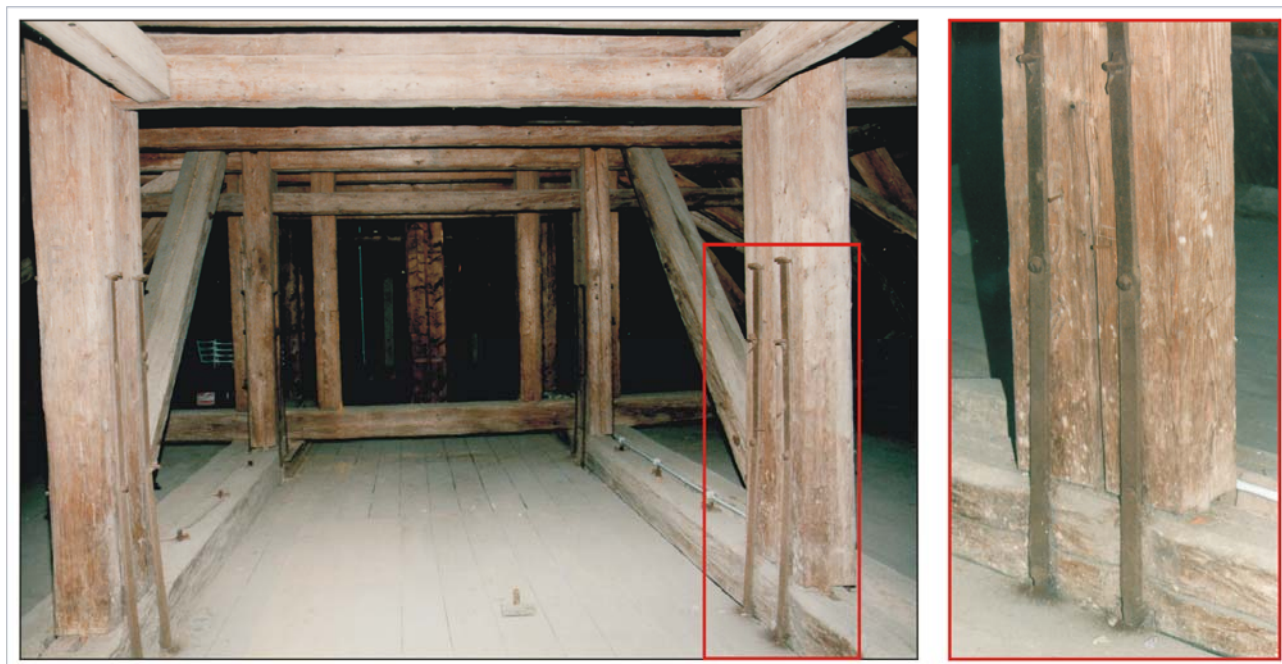
Bild 2.4.6: Schwebzapfen im Dachtragwerk der Weinbergkirche zu Dresden-Pillnitz. Infolge der Existenz doppelter Hängesäulen sind auch doppelte Schwebzapfen vorhanden.
