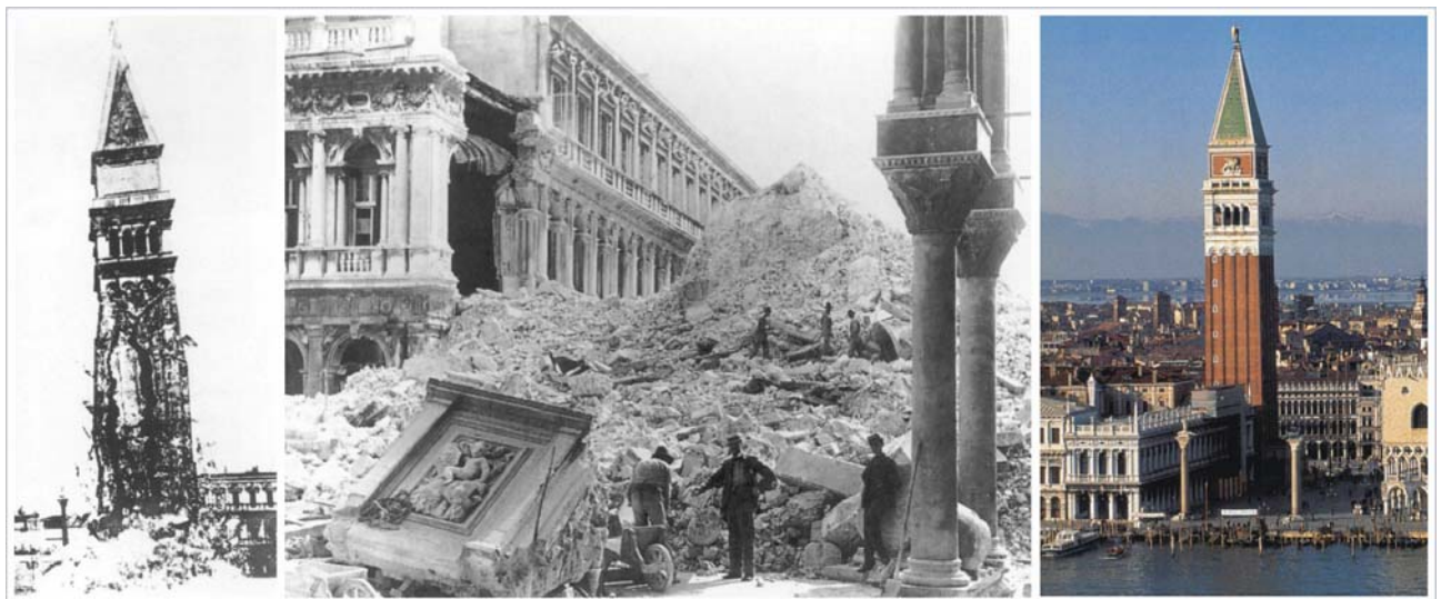
Bild I.1: Der Campanile von San Marco in Venedig. Einsturz des Turmes in einer historischen Fotomontage – Trümmerberg – Der wiederaufgebaute Campanile. 5
